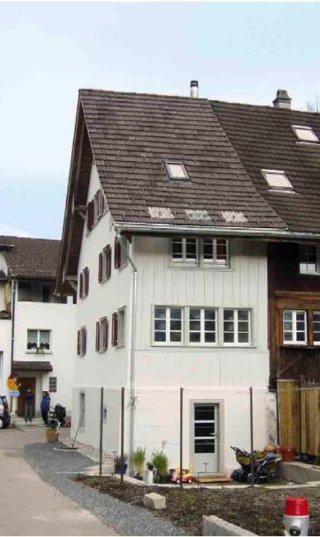
Der Blick von der Seite zeigt die spezielle Grundrissfläche des Hauses (3,5 x 9m) ^
