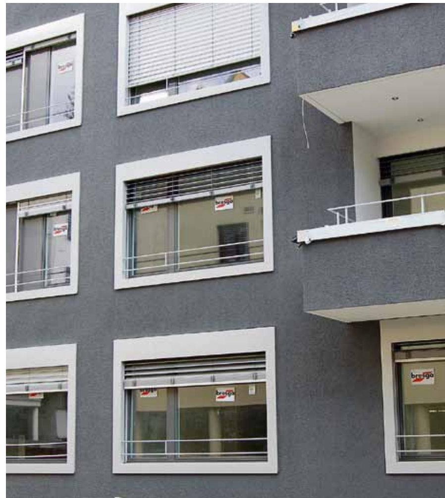
Gebäudeteile altern unterschiedlich schnell, und auch aus Kostengründen ist es oft sinnvoll, die Sanierung in mehreren, präzise abgestimmten Etappen durchzuführen.
