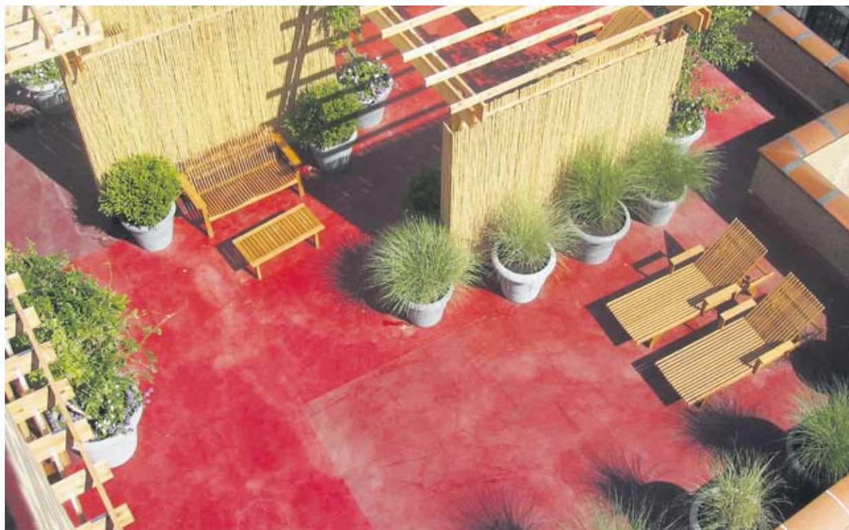
Dachterrasse mit neuem Belag (Bild oben). Der Flüssigkunststoff wurde mit Fellrollern aufgetragen.
