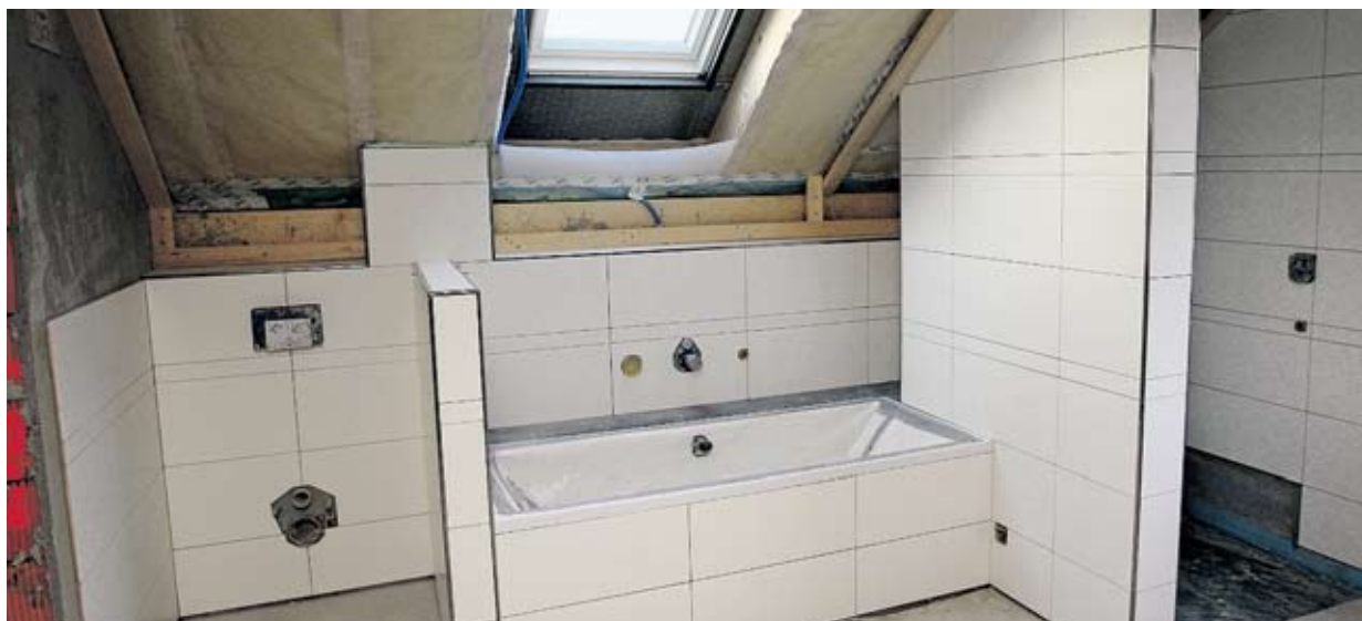
Aus einem ungenutzten Dachboden kann eine neue, helle Wellness-Oase entstehen. Wer Dach-Umbauten plant, sollte sich von einem Bauprof beraten lassen, damit es keine unbliebene Überraschungen gibt.
