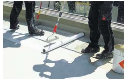
Dachterrasse mit neuem Belag (Bild oben). Der Flüssigkunststoff wurde mit Fellrollern aufgetragen.
