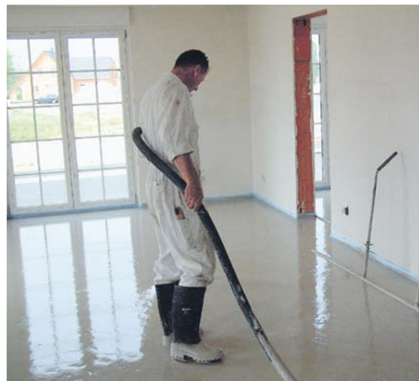
Der Fliessestrich überzeugt immer mehr Planer und Architekten. Der Einbau erfolgt einiges schneller und übertrifft die Leistungen mit konventionellen Zementestrichen um ein Vielfaches.
