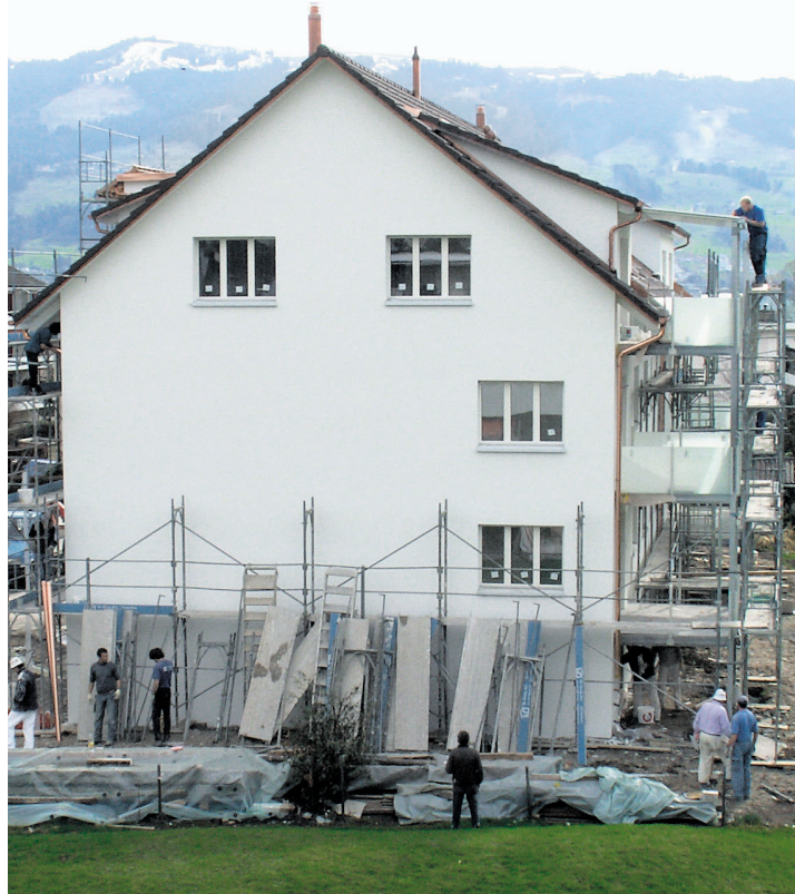
Gut beraten, ist halb saniert: Gesamtheitliches Sanierungskonzept bei einem Mehrfamilienhaus in Rapperswil. Bild: hbq bauberatung
