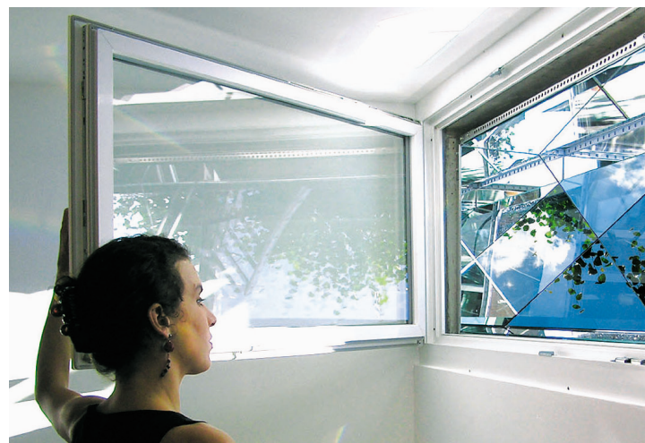
Dank Verspiegelung des Kellerschachtes - Luft und Licht im Souterrain. Bilder: heliobus
